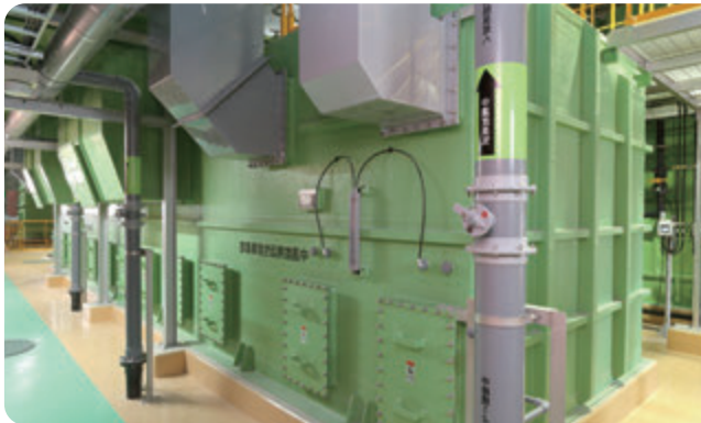
11 Tháp hấp phụ bằng than hoạt tính dùng cho nồng độ trung bình
