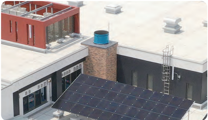
12 Chaminé de ventilação
