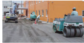
Material de relleno
