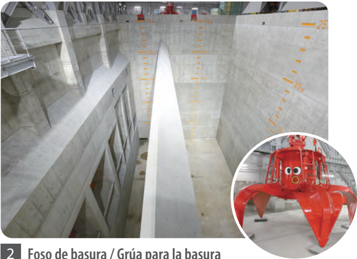
2 Foso de basura / Grúa para la basura La basura traída se vierte en el foso de basura de la parte delantera, luego se lleva al foso de basura de al fondo mediante la grúa de basura y se mezcla para que la basura tenga una inflamabilidad uniforme. El foso de basura puede almacenar aproximadamente 10 días la basura.
