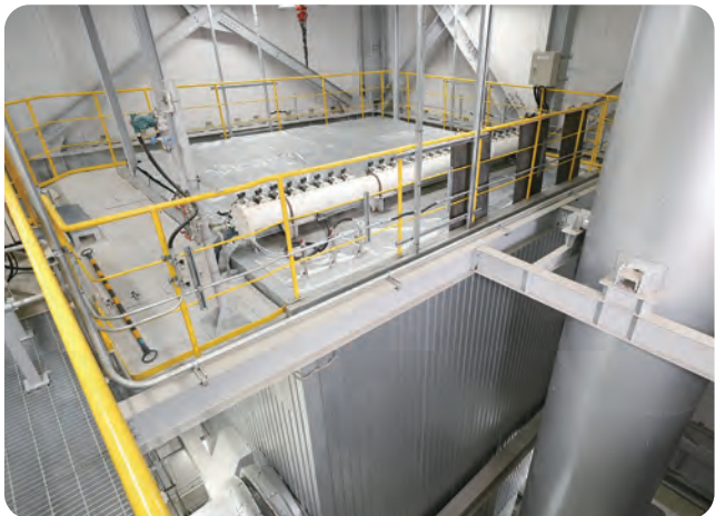
7 Colectores de polvo de filtración El hollín y las sustancias nocivas de los gases de escape son recogidos y eliminados por el filtro.
