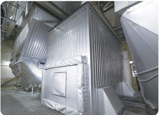
8 Torre de reacción catalítica Al hacer reaccionar con el catalizador los óxidos de nitrógeno nocivos de los gases de escape emitidos por el colector de polvo tipo filtro, se descomponen en gas nitrógeno y agua, y la pequeña cantidad de dioxinas restantes también se desintoxica.
