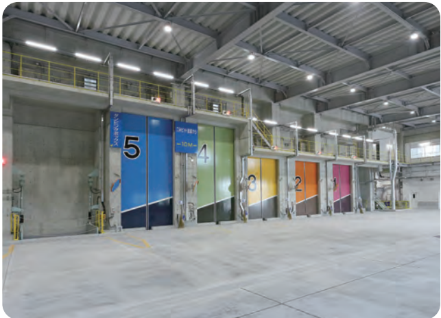
1 Plataforma El camión de basura se pesa con la báscula de basura, para luego entrar a la plataforma y echar la basura al foso de basura.
