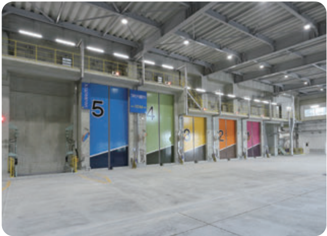
1 平台 垃圾称重机称重后, 垃圾车驶入平台, 将垃圾倒入垃圾坑。
